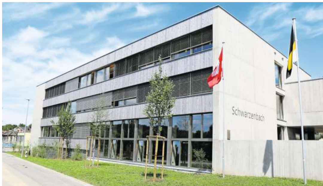
Nach 18 Monaten Bauzeit konnten die Schüler diesen Frühling den Neubau beziehen. Bild: Pablo Rohner
